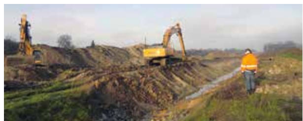
Herstellung des neuen Kanalseitengrabens im Winter 2013/2014
