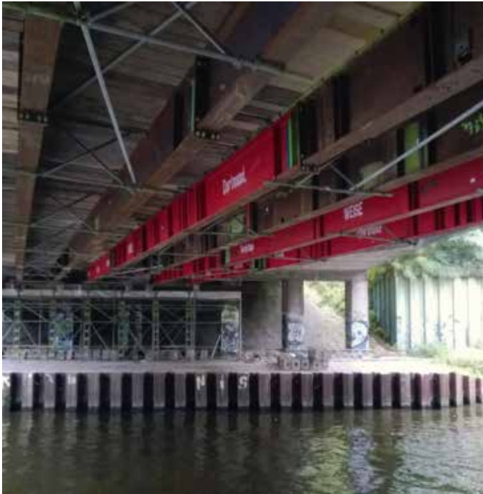
Aufwendige Rüstung unter der Sieversbrücke
