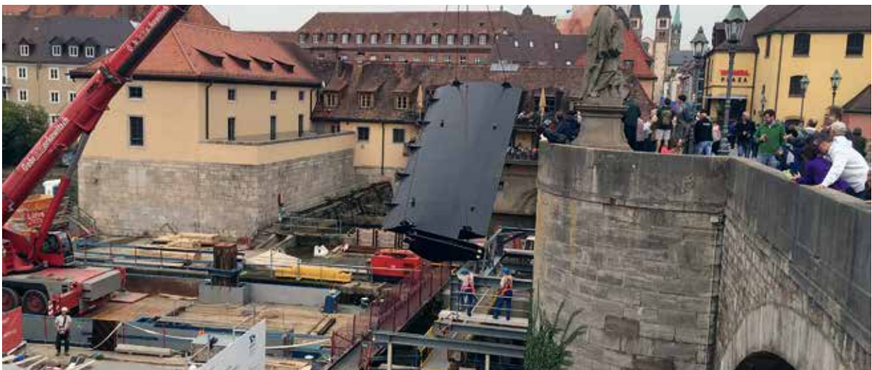
Einheben der neuen Fischbauchklappe
