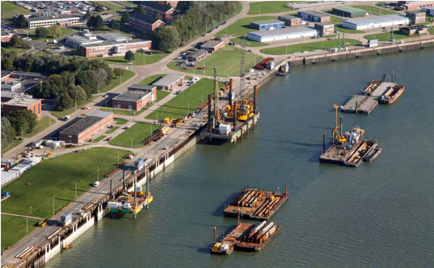
Westkaje Rammarbeiten Mai 2016
