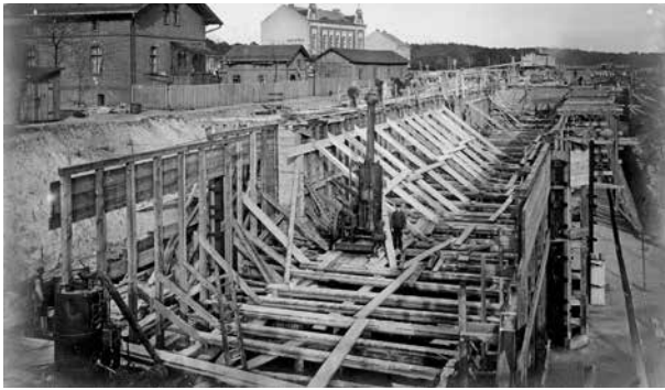
Bau der zweiten Schleuse Wernsdorf, 1903
