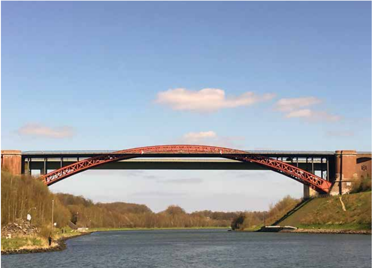
Die alte Levensauer Hochbrücke heute
