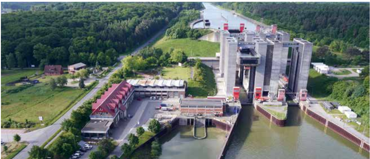
Schiffshebewerk Lüneburg und Bauhof WSA Uelzen
