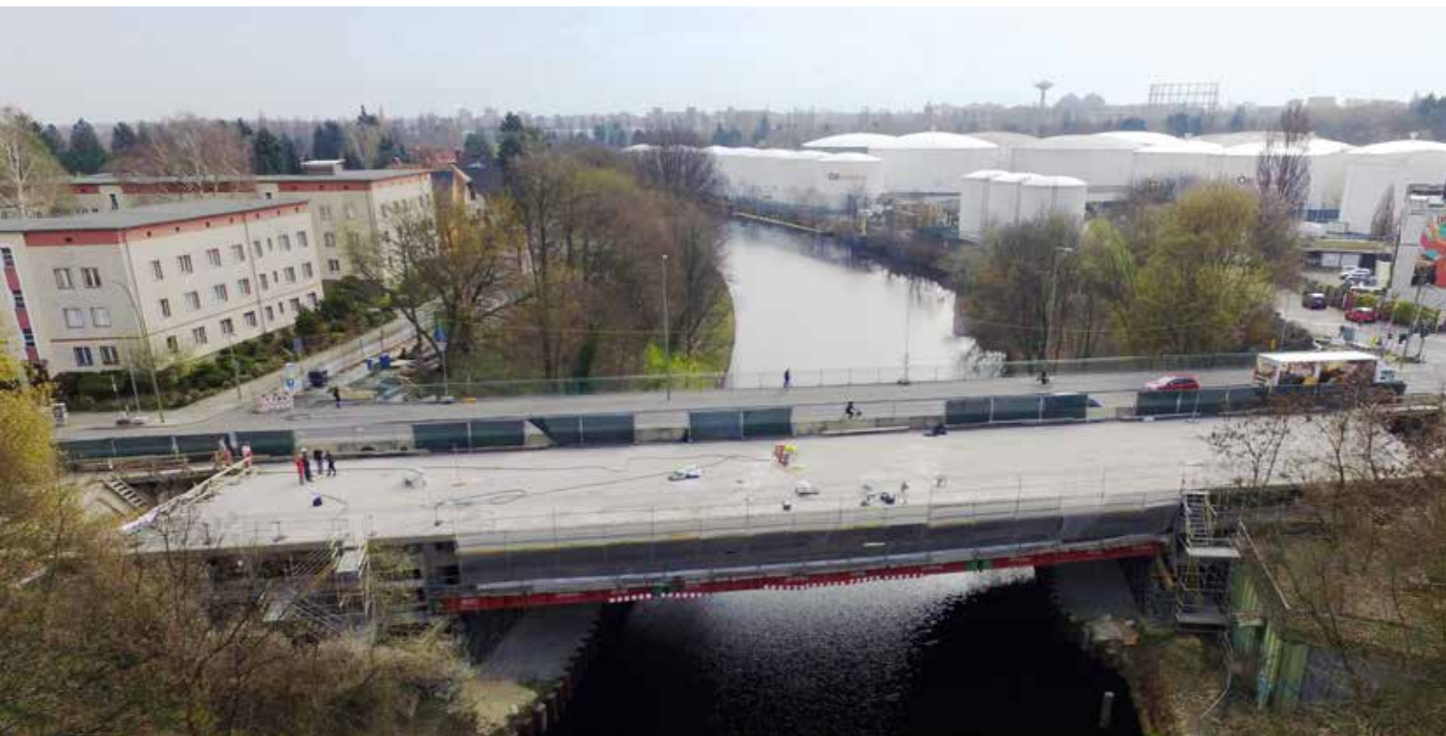
Luftbild Sieversbrücke Bauzustand
