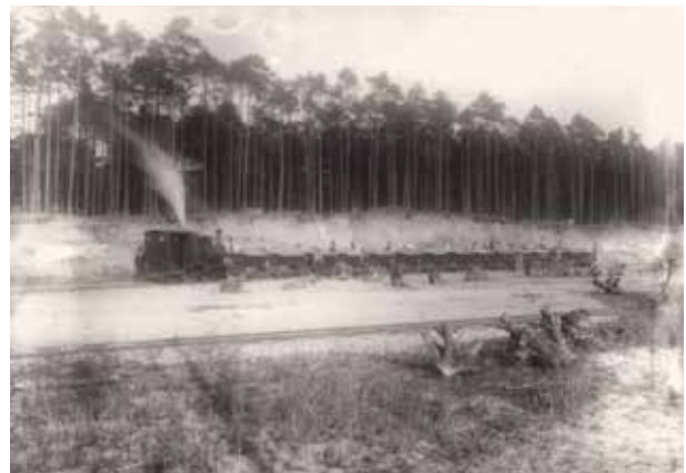
Kanalbauarbeiten im märkischen Sand, um 1888
