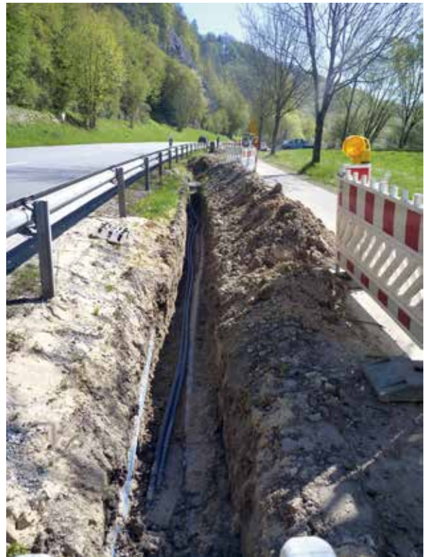
Verlegung des Kabelschutzrohres im offenen Graben
