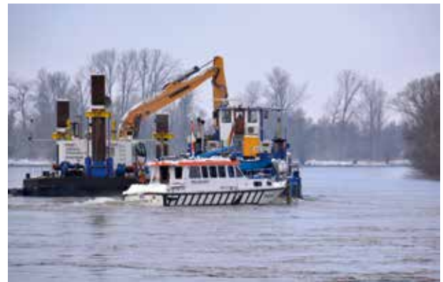
Peilschiff Tangens passiert das Baggergerät
