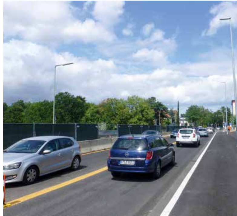
Verkehrsfreigabe für den 1. Bauabschnitt
