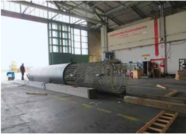
Herstellung von kunststoffbewehrten Fertigbetonpfählen
