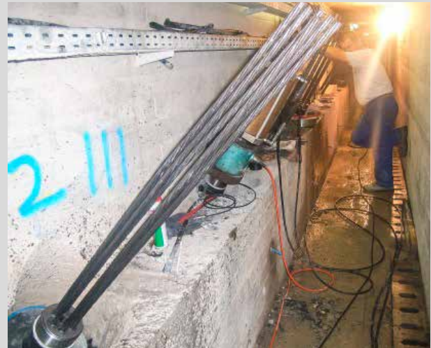
Einbau von Zugankern im oberen Wartungsgang
