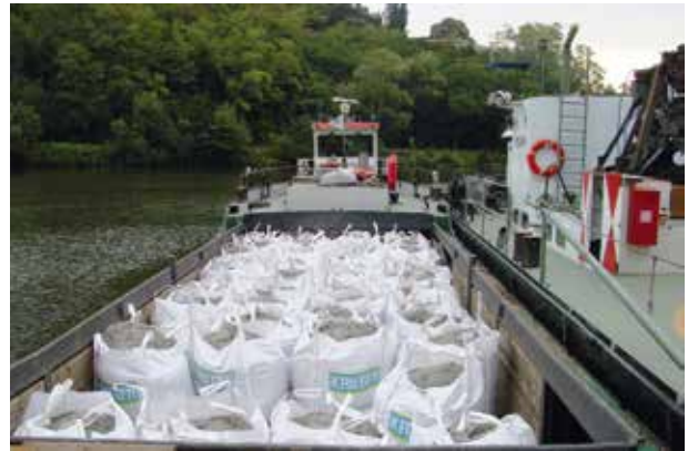
Bigpacks zum Verschließen des Nebengewässers
