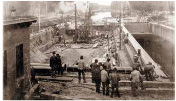
Bau von Nordschleuse und Sparbecken Schleuse Kersdorf, 1904
